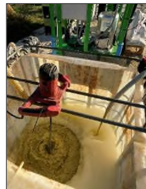
Preparazione miscela ed iniezione
