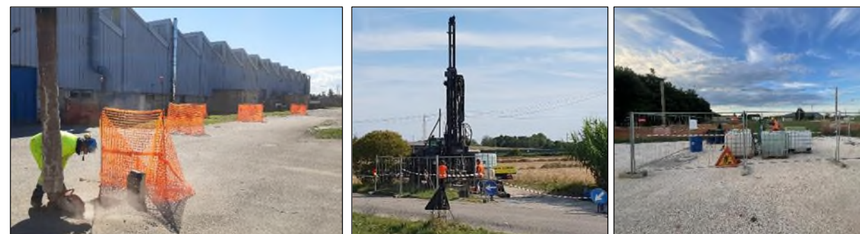
Segregazione e segnalazione aree operative
