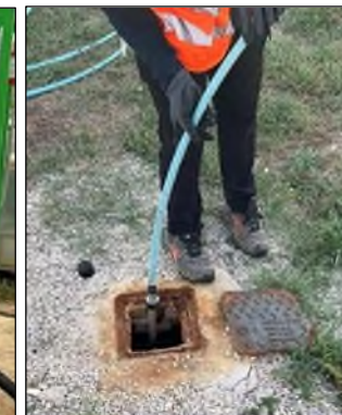
Manutenzione pozzi/piezometri
