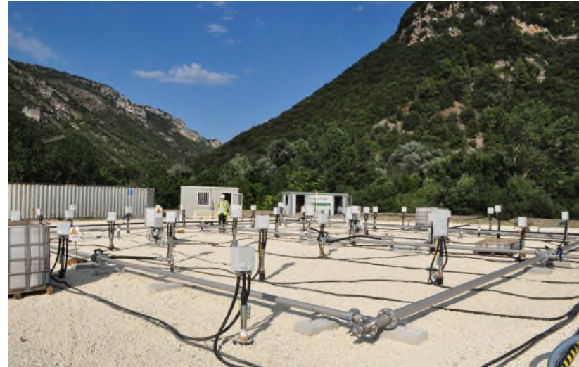
In-situ Thermal Conductive Heating (TCH) di un'area di 4000m2 impattata da Solventi Clorurati, IPA ed Esaclorobenzene. Bussi sul Tirino (Greenthesis e Tremonti spa.)
